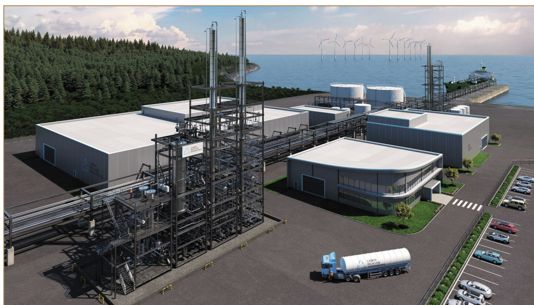
РИСУНОК 17. Трехмерная визуализация концепции интегрированного завода по переработке \text{CO}_2 в метанол производительностью 100 000 т метанола/ год [36].
