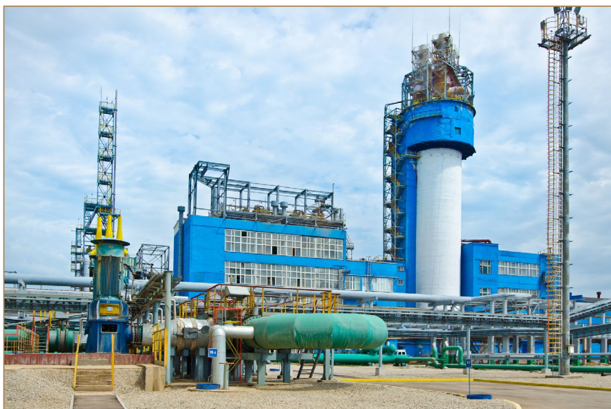
РИСУНОК 10. Производство карбамида на Газохимическом заводе ООО «Газпром нефтехим Салават» [23].
